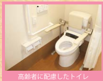
高齢者に配慮したトイレ
