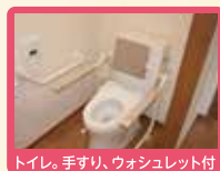
トイレ。手すり、ウォシュレット付
