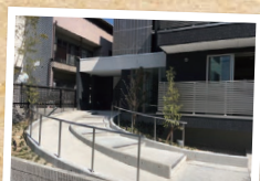
玄関スロープ
